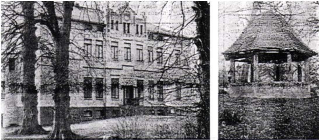
Das Gutshaus in Rakow und der im ehemaligen Park stehende verfallene Pavillon.
